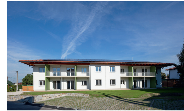
In diesem Jahr wurden in Hagenberg drei Wohnhäuser (zu je acht Wohneinheiten) in Modulbauweise mit Walmdach, Balkon und einer Tiefgarage mit 19 Stellplätzen errichtet
