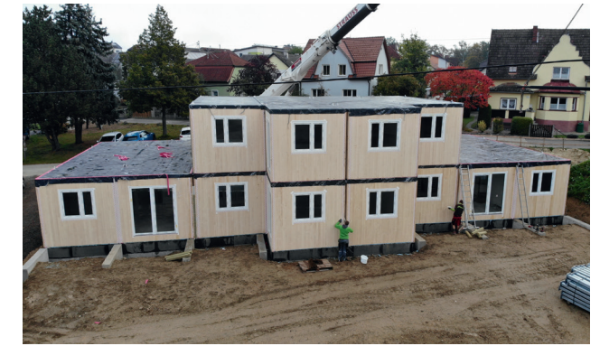
Die Wohnmodule sind im Vergleich zu konventionellen Bauweisen um etwa zwei Drittel leichter und werden vor Ort auch schlüsselfertig samt Möbeln zusammengesetzt
