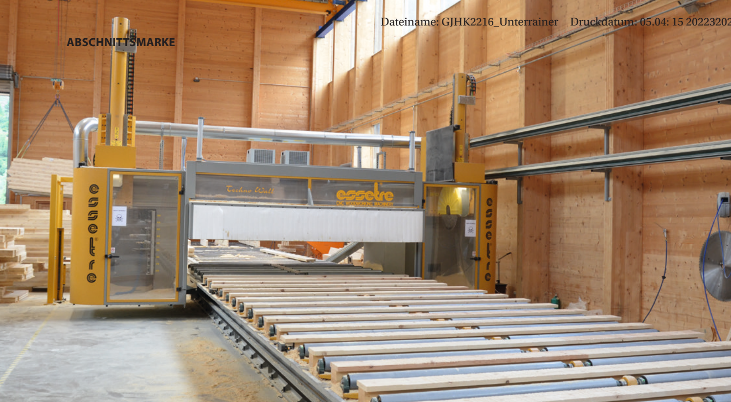
Das Portalabbundzentrum von Essetre übernimmt bei Holzbau Unterrainer den Abbund der gesamten BSP-Produktion
